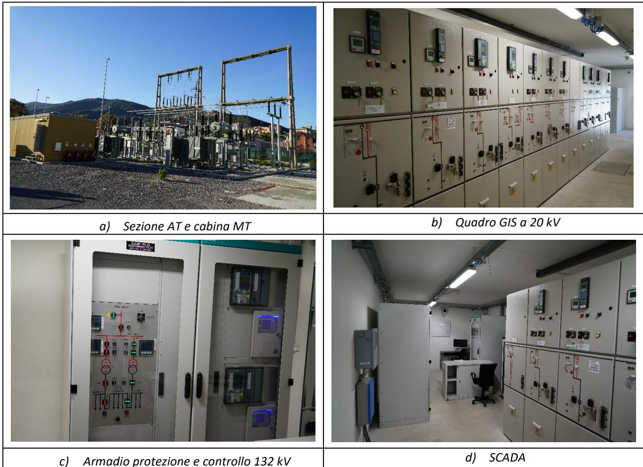
Fig.30 La sottostazione AT/MT del Porto di Vado Ligure
